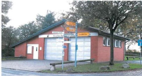
Das Feuerwehrhaus in Großkönigsförde entspricht nicht mehr den Anforderungen. Ob es ein Umbau oder ein Neubau wird, ist unklar.
