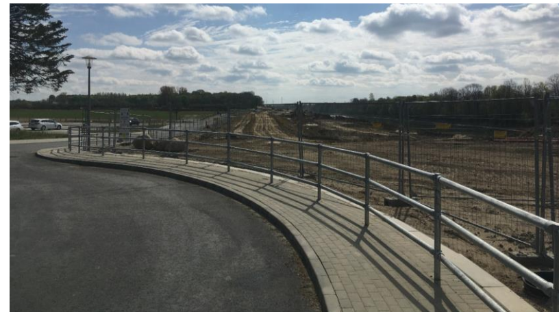
Abb.: NOK in Lindau vor (2018) und während des Umbaus (2020) Quelle: inspektour GmbH, 2018/ 2020
